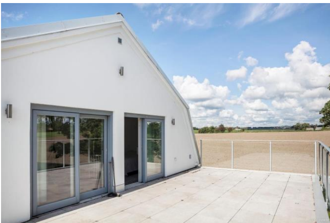
Balkong med glasrÄcke och spotlights ov
